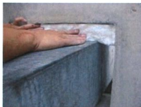
2. 對於較大孔洞可先在內部填塞礦纖棉輔助
