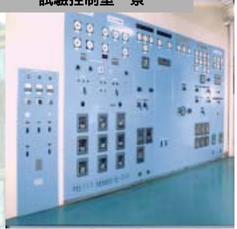
試驗控制室一景
