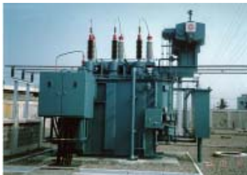
台電公司超低噪音變壓器 69kV-25MVA (50dB)
