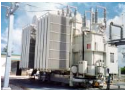
外銷關島電力變壓器 115kV-112MVA
