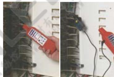
注：両隣の電線が若干反応するなど、該当ブレーカの特徴が困難なときは、クランプセンサを使用してください。
